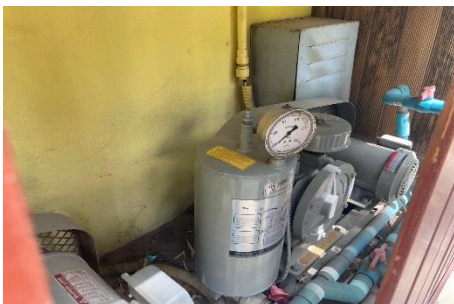
ภาพที่ 19 เครื่องเติมอากาศบ่อน้ำบาดน้ำเสีย
