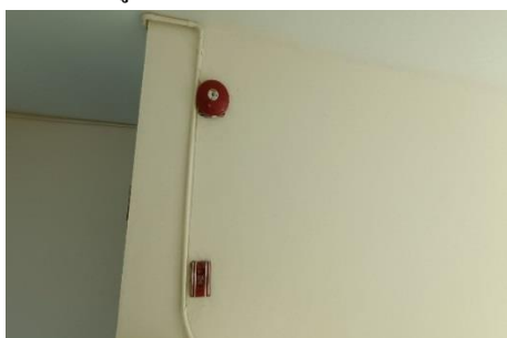
ภาพที่ 45 ระบบ Fire Alarm
