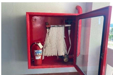
ภาพที่ 47 ตู้เก็บอุปกรณ์ดับเพลิง
