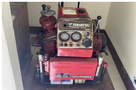
ภาพที่ 50 เครื่องดับเพลิงเคลื่อนที่
